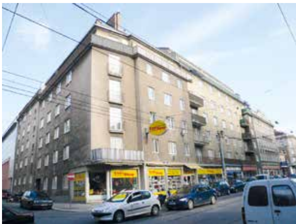
Modernisation project in Hütteldorfer Strasse, Vienna
